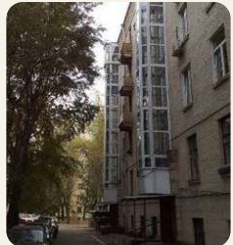
Рисунок 1.32. Приклади прибудови ліфта до сумісного зі сходовою кліткою приміщення
